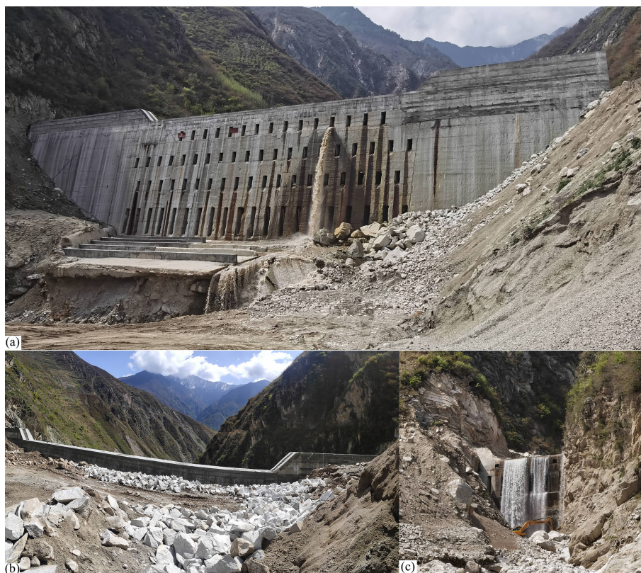
图 9 流域内清理防护工作:(a) 拦沙坝 1;(b) 拦沙坝 1 内的物源状况;(c) 拦沙坝 2
