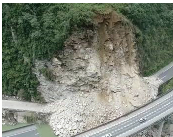
图 7 崩塌失稳后无人机影像显示花岗岩体破碎
