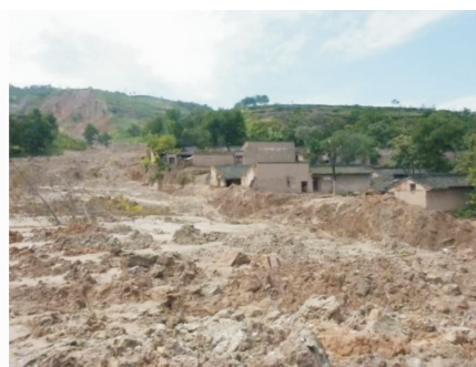
图5 大沟泥石流发生后道路、房屋淤埋情况 [4]
