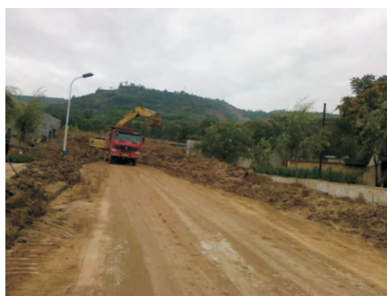
图5 大沟泥石流发生后道路、房屋淤埋情况 [4]
