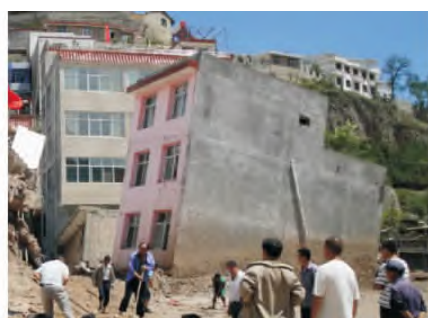
图4 整体倾斜破坏(赵书平 2010年8月8日)
