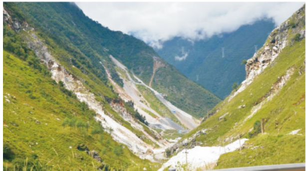
图 11 矿产露采 - 崩塌 + 滑坡 + 碎屑流 - 环境破坏 + 矿区损害
