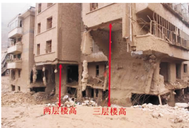
图 6 破坏作用沿纵向递减
