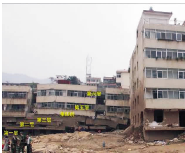
图3 泥石流对建筑物的间接破坏
