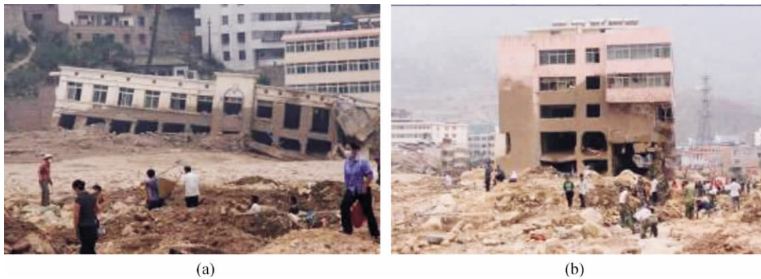
图 4 正向撞击破坏( a. 建筑 E; b. 建筑 C)
