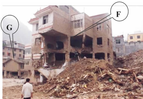
图 5 泥石流的侧向淤埋破坏
