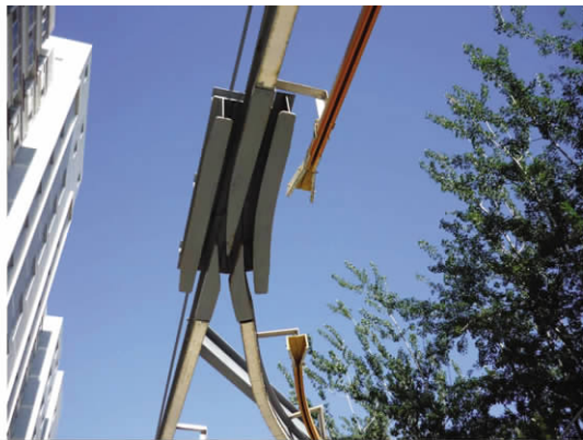
图6 北方工业大学实验轨道道岔
