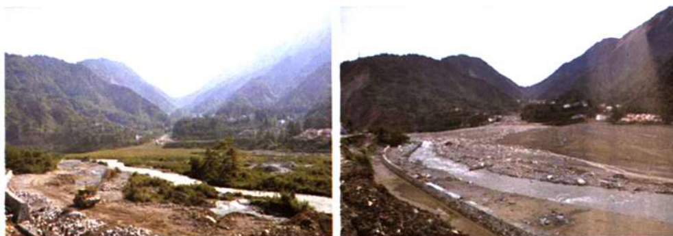
图8 走马岭沟和罗家沟 2010-08-13 泥石流前后对比(左图中左侧的防护堤已被完全淤埋)
