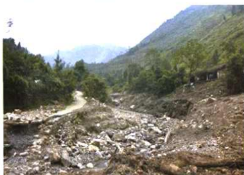
图2 烂泥沟内泥石流冲毁公路
