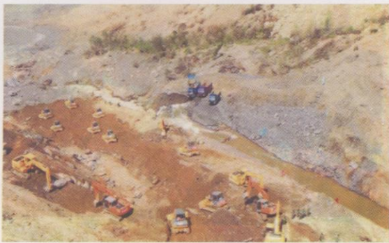
图 5 泄流槽旁新施工的引流槽
