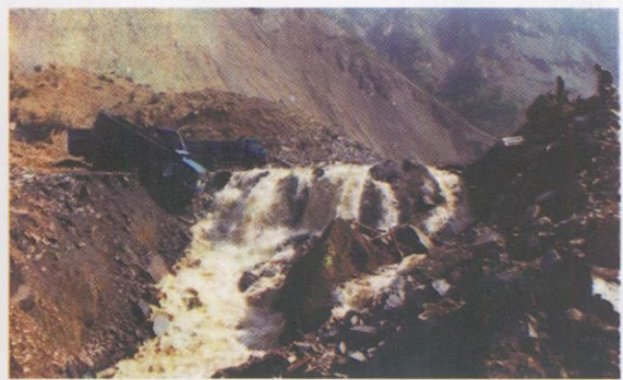
图 6 泄流槽出口的巨石阻止沟道下切
