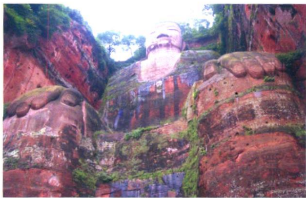
图3 孔洞多风化严重的乐山大佛
