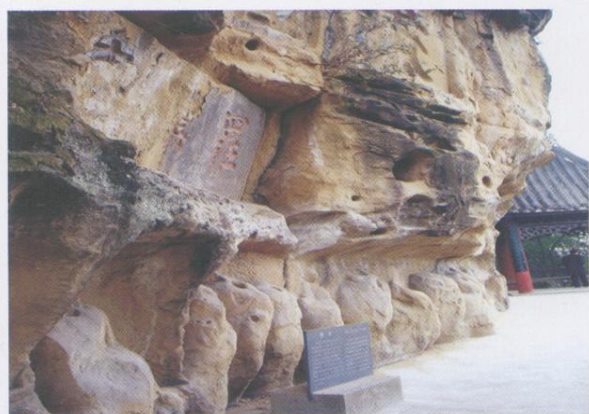
图 2 荣县大佛两侧小佛像风化剥蚀程度强烈
