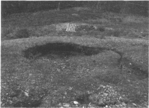
图 3 41#平硐内 15m 硐顶上方形成的塌陷天窗
