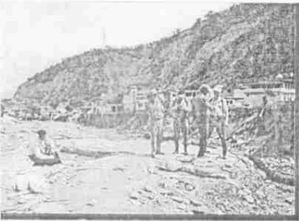
照片 7. 泥石流摧毁卡门德乌里亚(Uria)的建筑物后冲出的沟槽
