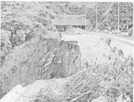
照片 5. 泥石流、滑坡毁坏高速公路, 堵塞隧道 (加拉加斯至玻利瓦尔国际机场)
