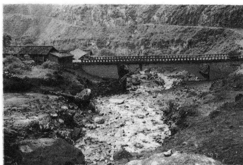
照片 10 滑坡物质进入主沟后转化成大规模泥石流(流速 4\text{m/s} ,流量约 540\text{m}^3/\text{s} )
