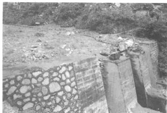
照片 5 新寨子沟 1#, 坝上部平面格栅只占坝长的 1/4, 排细效应有限
