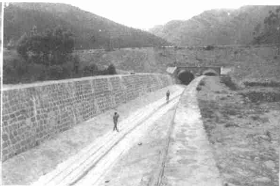
照片 2 瓦磁沟沟床磨损速度很快
