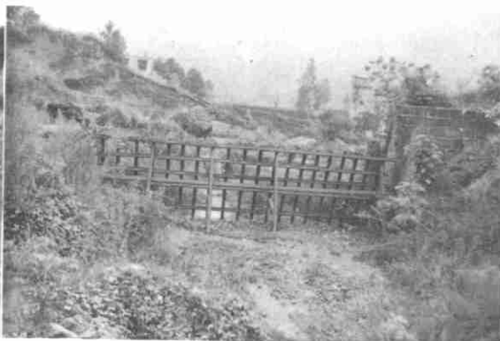
照片 4 峨边砂槽沟,1991 年建的钢轨格栅坝,基础为锚定板,运行状况良好
