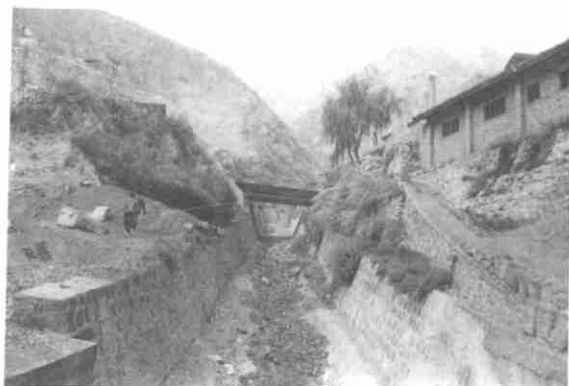
照片 3 拉古子沟,1989 年改建的窄深式排导沟,排导效果良好,成功地排泄了一次较大规模的泥石流
