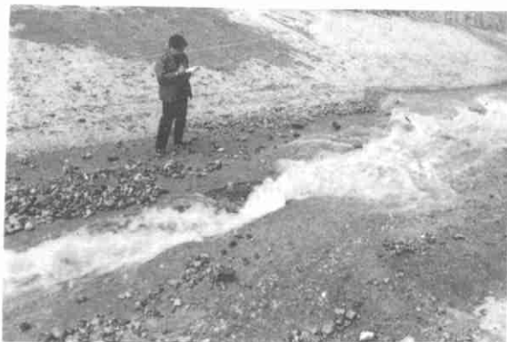
照片 1 姆古足沟,1989 年建的尖底排导沟沟床磨损情况
