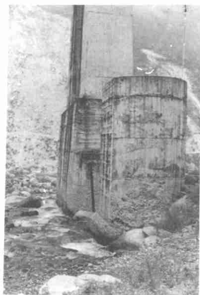
照片 6 龙门沟大桥下,1990 年建的防护墩已经受了 1991 年泥石流考验,效果较好
