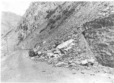
照片 2 独山子—库车公路 70K+300 处被落石型倒石堆摧垮的挡墙
