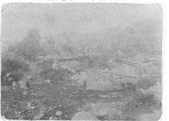
照片 12 水石流冲刷形成的 3.8 米高跌坎
