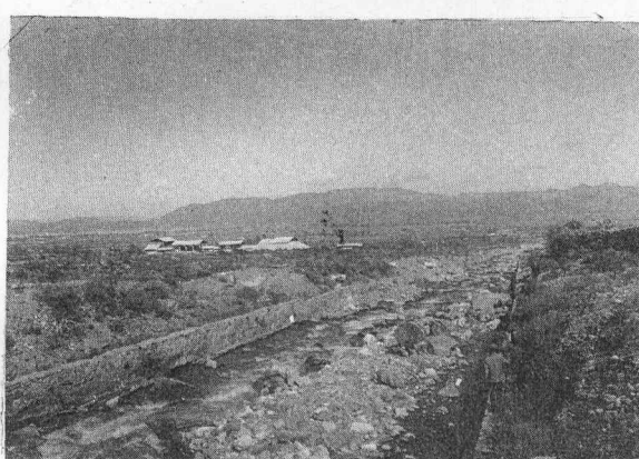
照片 10 水石流在槽内摆动, 造成集中冲刷
