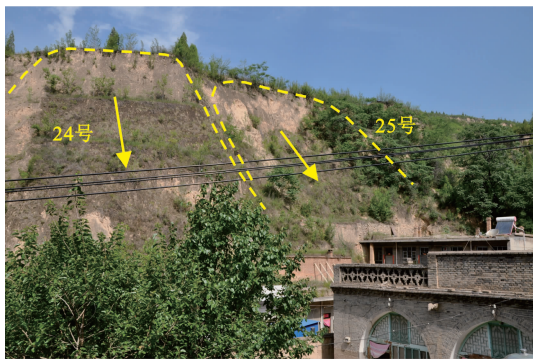
图 3 大宁县城城区幸福沟西坡浅层滑坡
