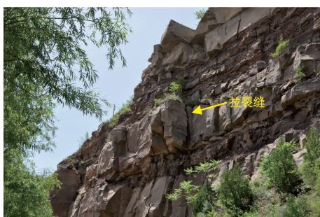
图 11 公路沿线岩质边坡悬空拉裂(8号)
