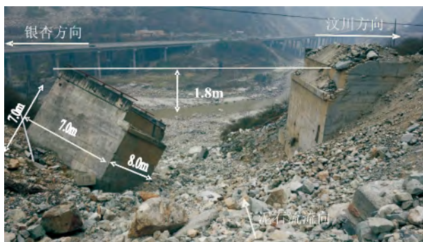
图4 泥石流作用下桥梁破坏
