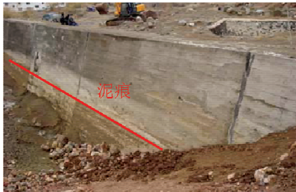
图 29 滑坡发生前暴发过小型泥石流
