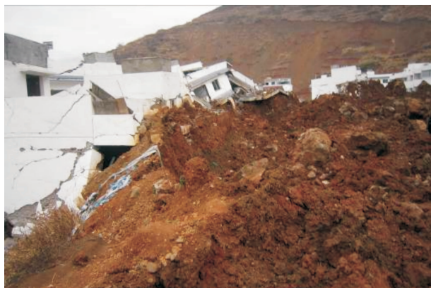
图3 滑坡导致房屋倾倒破坏
