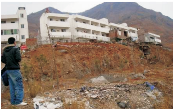
图 22 灰岩顺层古滑坡堆积体
