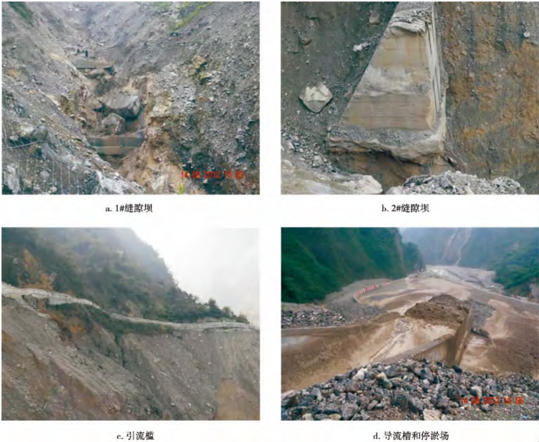
图 4 2012 年小岗剑沟泥石流治理工程受损情况
