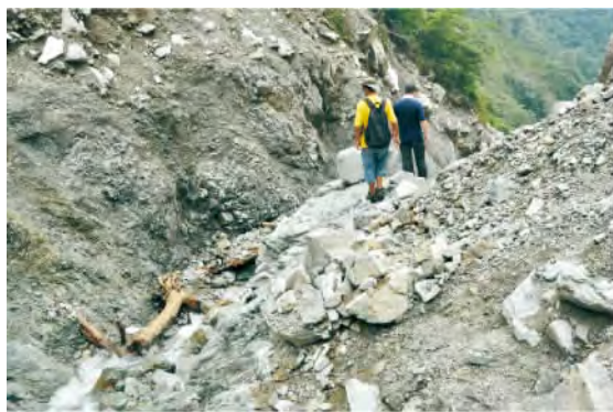
图 2a 堵塞体坡脚被掏蚀
