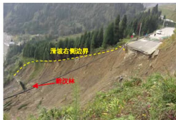
图11 主滑体右侧垮塌及堆积区Ⅲ上的醉汉林(镜向210°)
