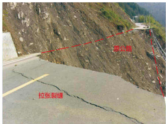
图1 鬼招手滑坡后缘公路垮塌及路面的拉张裂缝(镜向60°)
