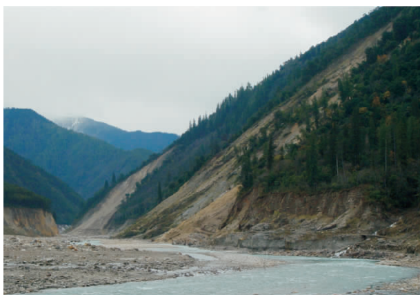
图 3 溃决洪水冲刷河谷坡脚引发崩塌滑坡毁坏公路
