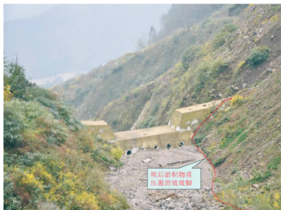
图8 谷坊坝稳固滑坡
