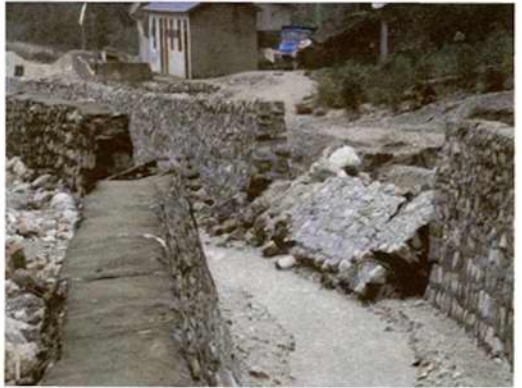
图8 泥石流冲毁已建排导槽
